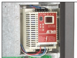
velocidad variable impulsión del motor
